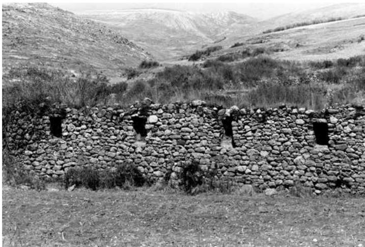
*Figura 5.8.* Sección de muro de pirka (piedra rústica) con hornacinas de forma trapezoidal al estilo imperial.
