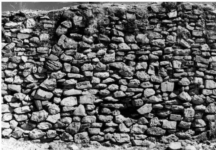
Figura 5.7. Sección de la cara sureste del usnu de Hatun Xauxa, que muestra áreas originales (tres cuartos a la derecha) y reconstruidas (un cuarto a la izquierda).
