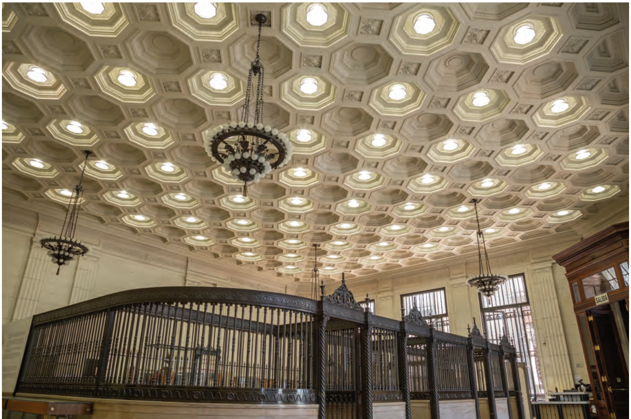
EL TECHO DEL PRIMER PISO DEL MUCEN, UNA NOVEDAD EN EL ARTE DE CONSTRUIR EN LA DÉCADA DE 1920.
