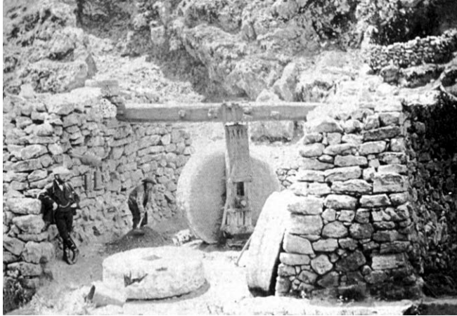
Ingenio de moler minerales de la hacienda Milpa (¿Cerro de Pasco?), c. 1875. (Tomado de: C. Contreras y N. Majluf, Registros del territorio: las primeras décadas de la fotografía . Lima: Museo de Arte de Lima, 1997)
