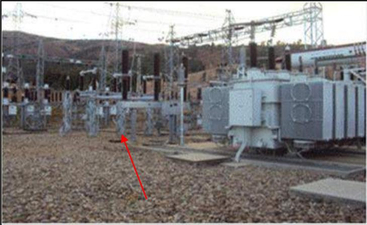
Modificación Celda de Llegada 60kV Modulo Transformador 25/28 MVA S.E Cajamarca
