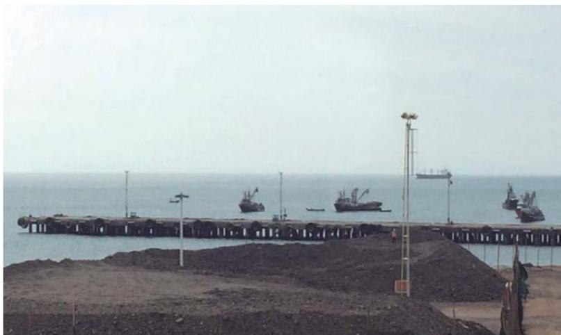
El muelle cuenta con un espigón de 302 metros de largo y 27 de ancho con sistema de iluminación. El muelle es multipropósito, es decir, tiene capacidad de manejo de carga fraccionada, a granel, rodante, de contenedores y de minerales.
