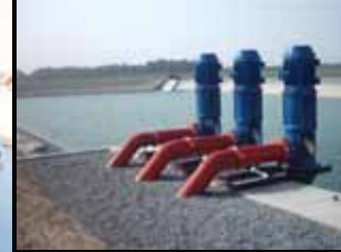
Obras de Riego
