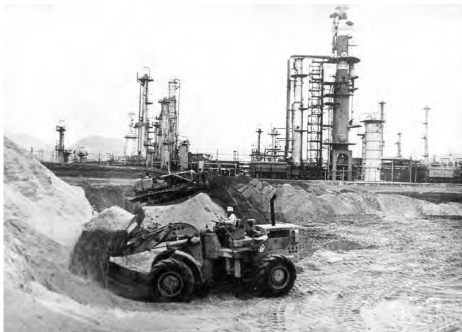
Construcción de la refinera La Pampilla, c. 1970 (archivo diario El Peruano ).
