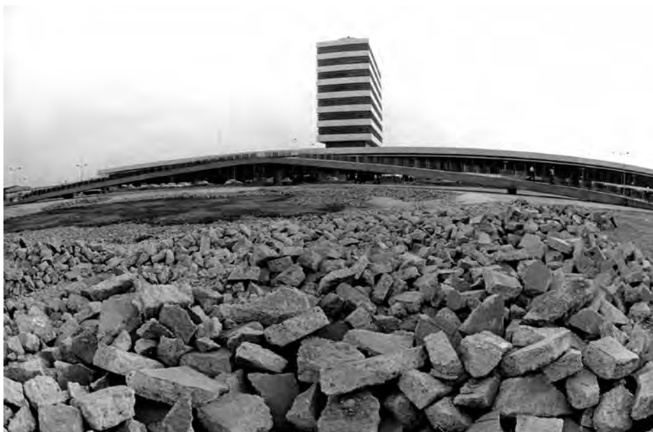
Construcción del aeropuerto Jorge Chávez durante el gobierno de Belaunde (archivo diario El Peruano ).
