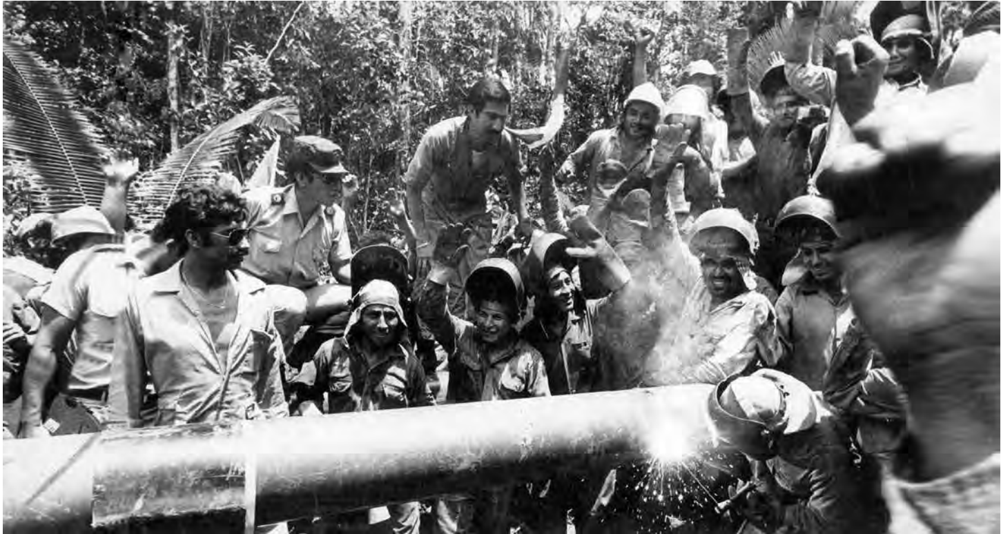
Obreros en plena construcción del Oleoducto Norperuano en los años setenta (archivo diario El Peruano ).
