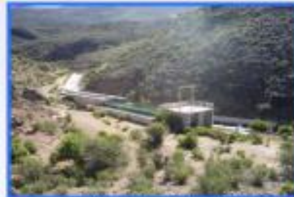
Salida del túnel terminal Quebrada Querque
