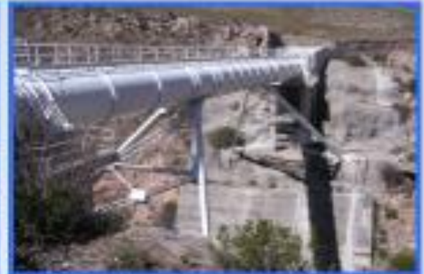
Acueducto de acero en Quebrada Matadero (80 m)
