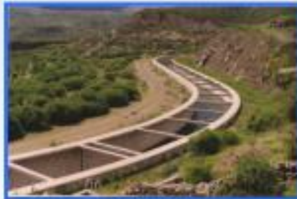
Canal de Aducción
