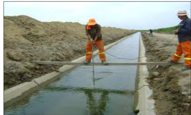
Medición de caudales en canales de riego
