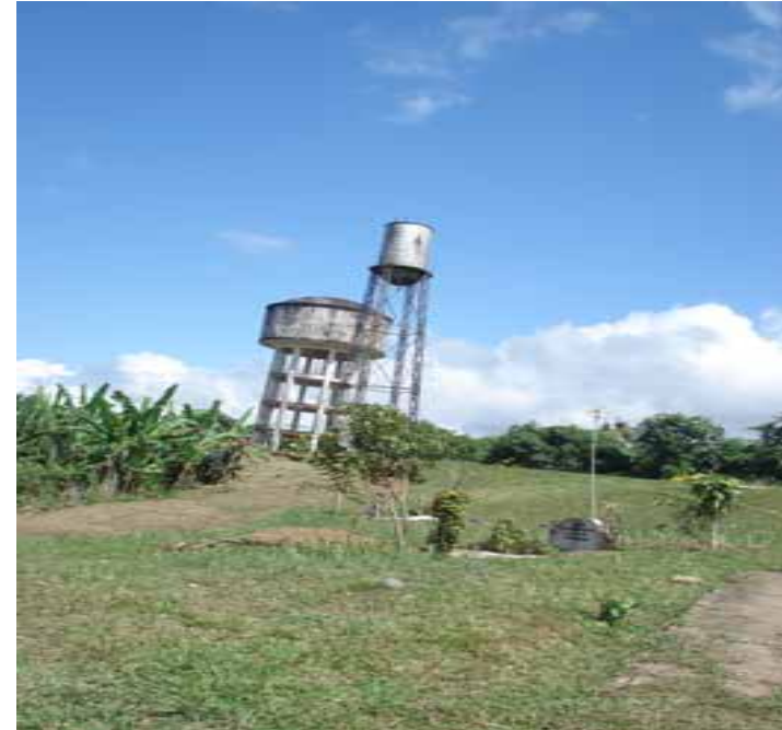
Vista panorámica de la zona del tanque elevado a ser rehabilitado. Al costado se aprecia tanque metálico a ser desmontado.
