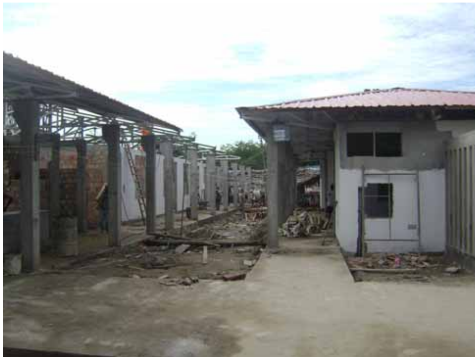
Obra en plena construcción. Octubre 2009.
