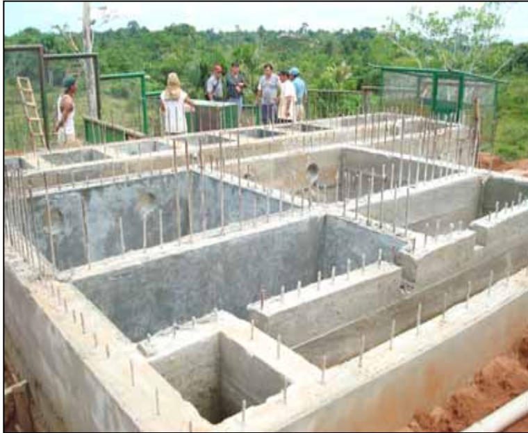
Vista de la Planta de Tratamiento en construcción.
