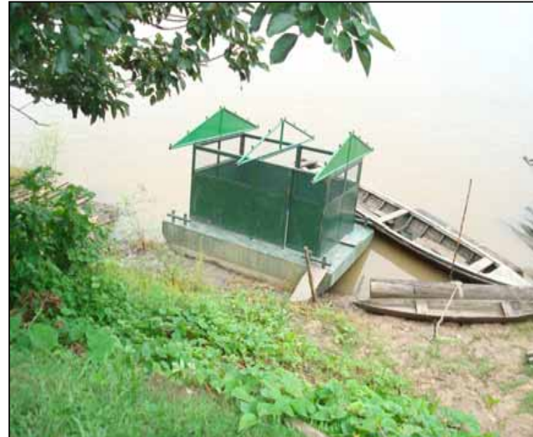
Vista del Pontón de Captación del Sistema de Agua.
