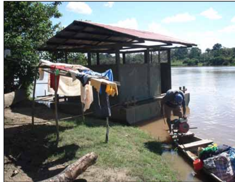
Vista del Pontón de Captación del Sistema de Agua.
