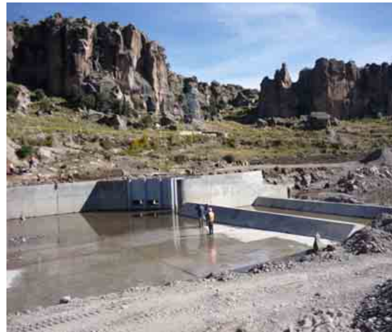
BOCATOMA EN EL PROYECTO CAÑÓN DE APURIMAC 3 M 3 /SEG
