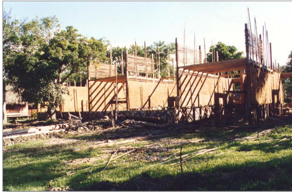
Construcción de Puerto Patos Tarapoto Lodge
