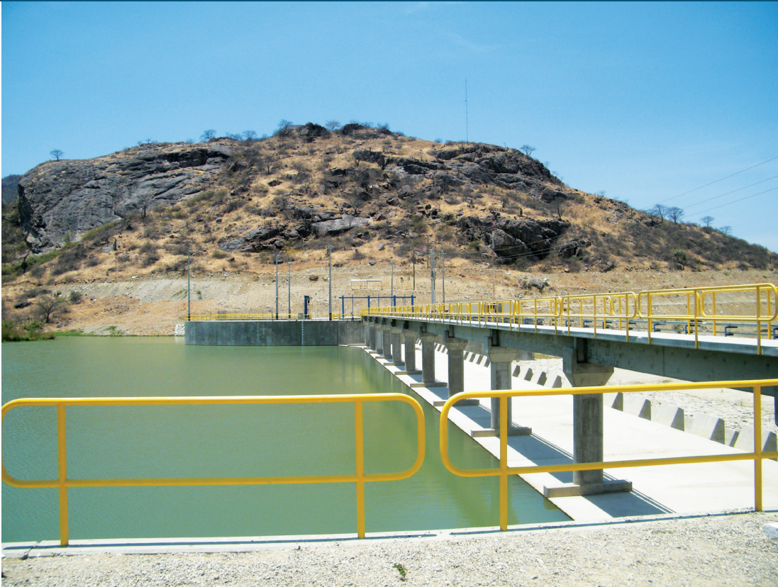
BOCATOMA MIRAFLORES: UNA DE LAS DOS ESTRUCTURAS DE CAPTACIÓN Y CONDUCCIÓN DE AGUAS DEL RÍO OLMOS.
