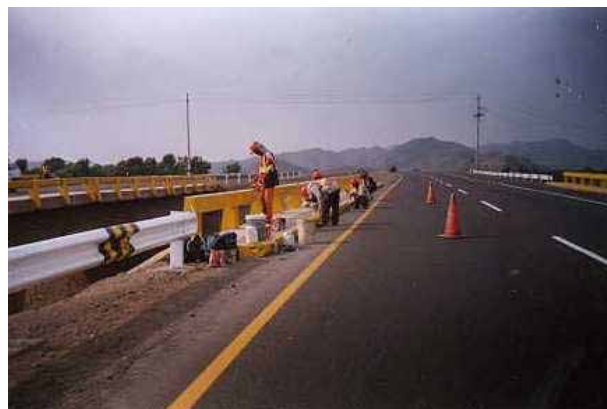
Limpieza de guardavías
