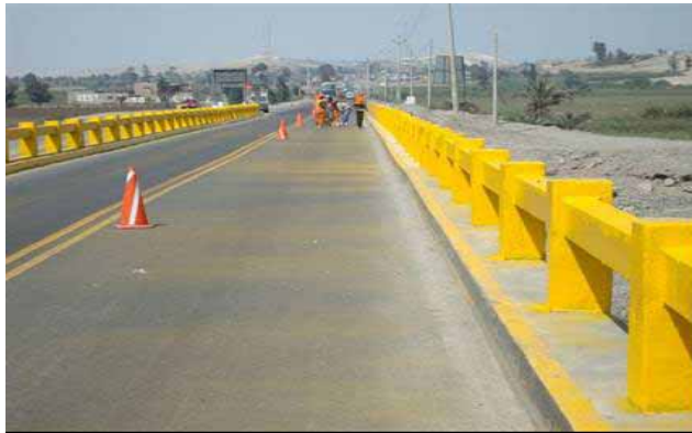
En la vista se puede observar al personal realizando la limpieza de los puentes
