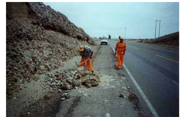
Personal realizando limpieza de derrumbes
