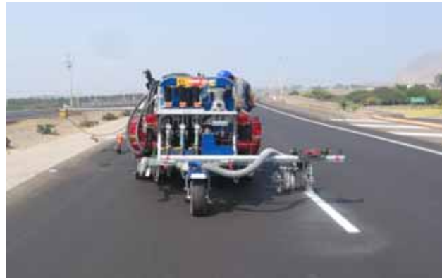
Personal realizando pintado de señales en el pavimento
