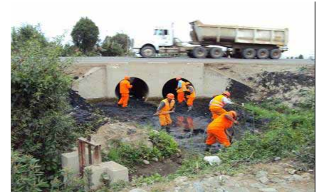
Limpieza de alcantarilla
