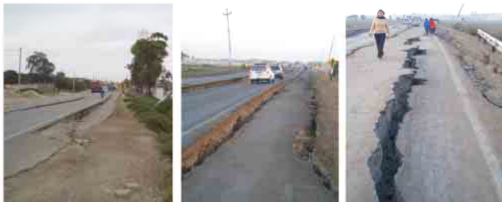
F-4.10.1 Grietas en la carretera Panamericana, cerca del cruce con el río Pisco. La humedad del suelo la debilitó.
