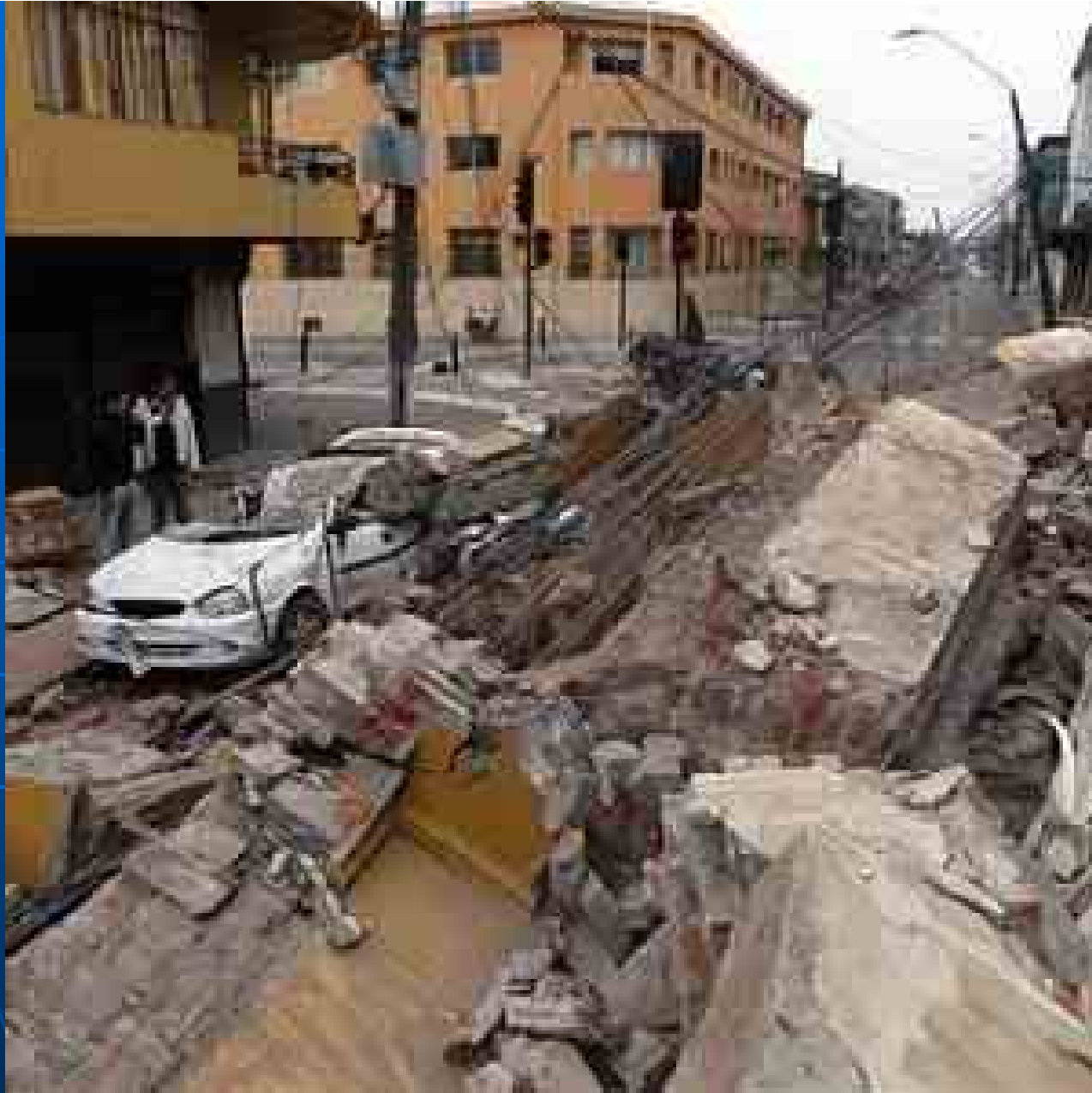
Edificio en Concepción que colapsó sobre la calle
