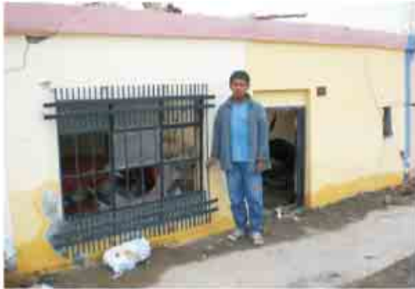
F-4.13.1 En Tambo de Mora hubo licuación generalizada de suelos. Numerosas casas se hundieron unos 80 cm. En Calle Nueva se hundió una fila de viviendas.
