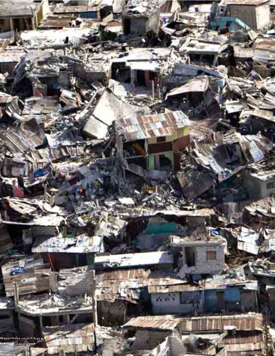
Daños en casas
