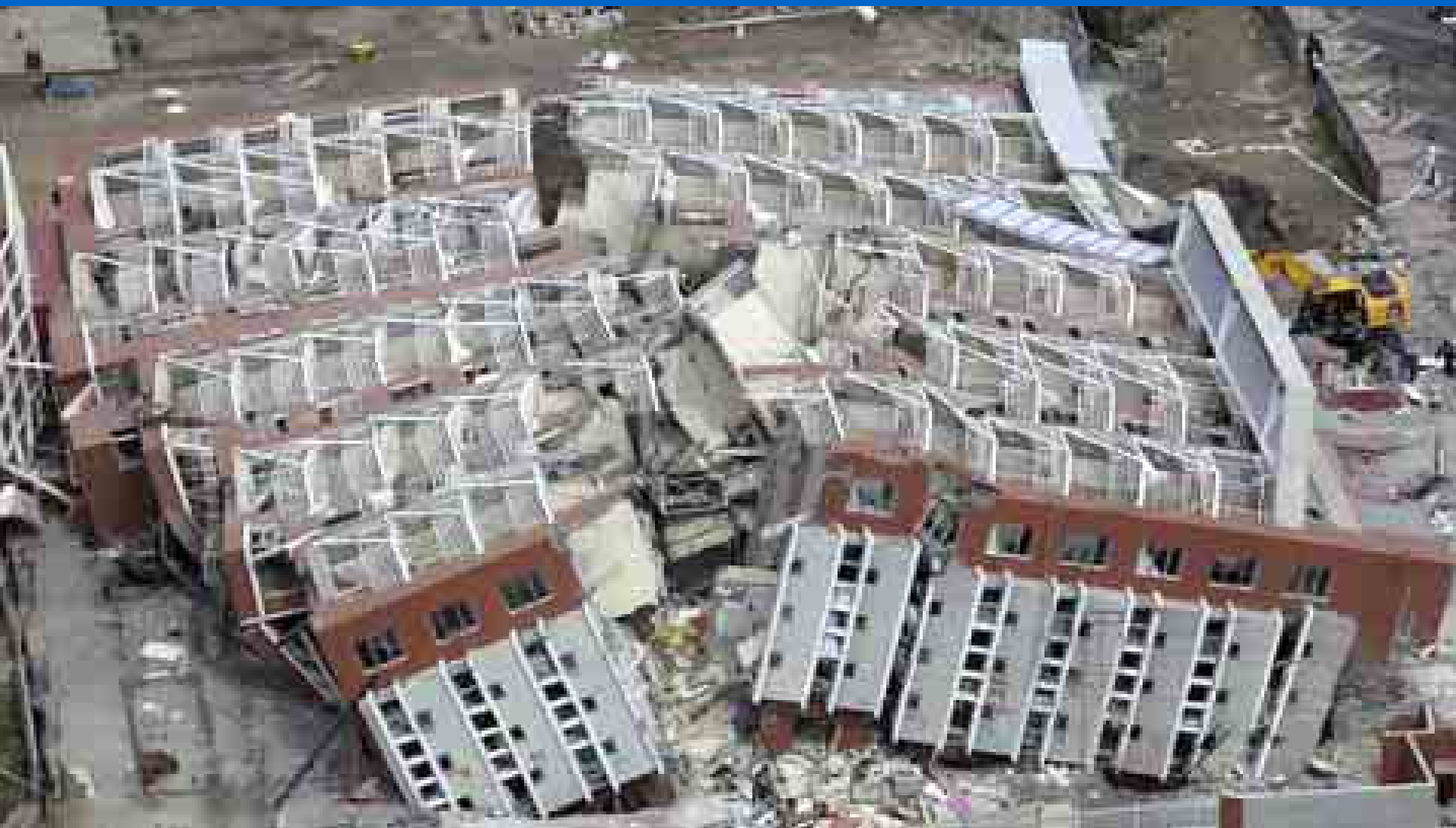
Edificio de departamentos
