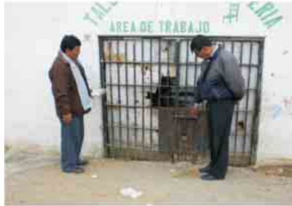
F-4.13.2 La cárcel de Tambo de Mora se hundió entre 60 y 80 cm.
