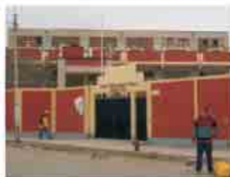
Colegio Julio C. Tello (sin daños).
