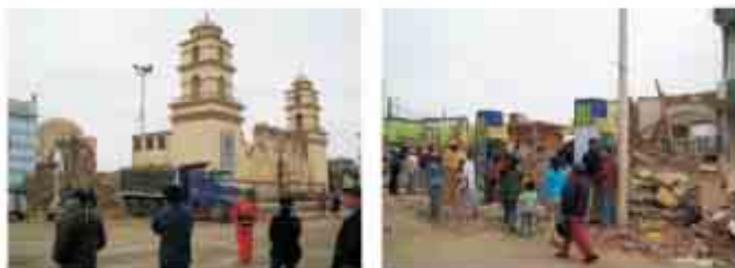
F-4.10.3 Daños en la Plaza de Armas de Pisco. La nave central de la catedral colapsó.
