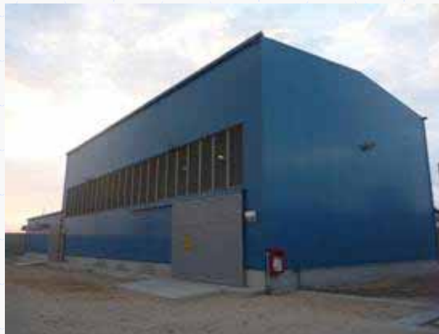
Vista Panorámica de la CT
