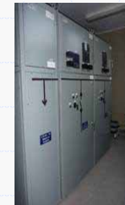
Alimentación Línea 4.16 kV a Planta de Fundición
