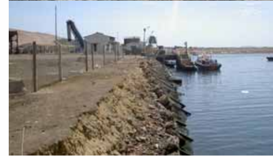
Talud y cerco norte/sur
