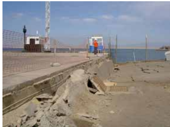
Plataforma de relleno
