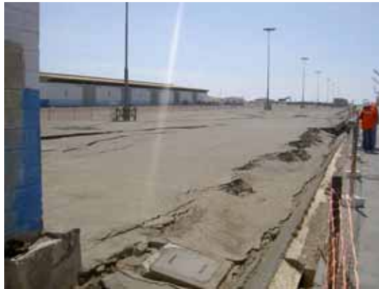
Plataforma de relleno
